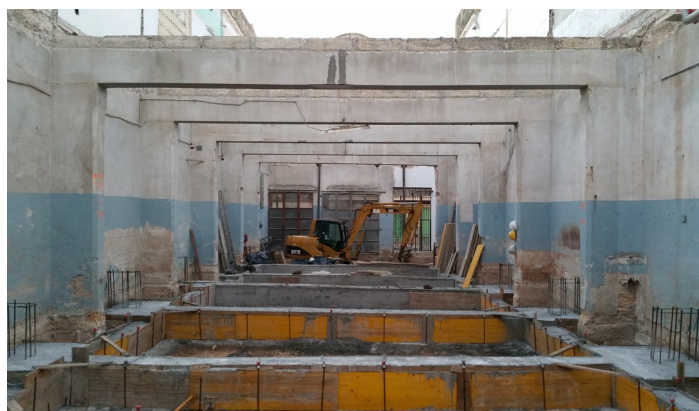
Figura 3. Obres de cimentació del futur arxiu, 2015. Xavier Morlà Cuesta.
